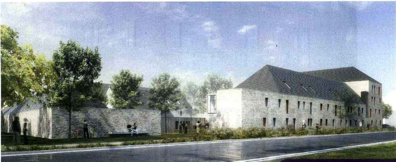
Bruyères-sur-Oise (Val-d'Oise). L'office public de l'habitat Opievoy réalise un programme BBC de 57 logements sociaux répartis en collectifs et maisons individuelles. Le projet architectural s'inspire de l'habitat rural ancien d'Ile-de-France. Démarrage des travaux : premier semestre 2012. Architectes : Pierre Lépinay et Bertrand Meurice.
